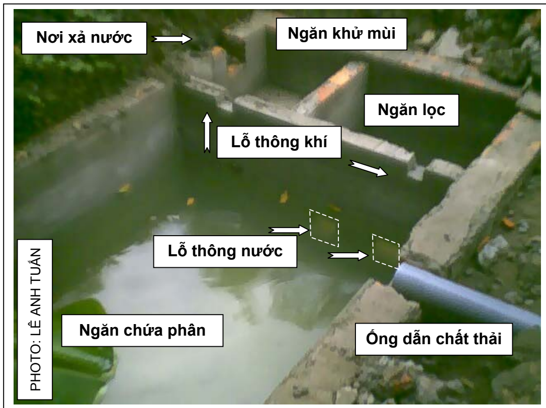
Hình 4.14: Kết cấu một hầm chứa tự hoại đang quá trình xây dựng
