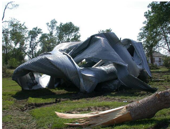
Hình 4.10: Một mái công trình bị lốc cuốn xoáy và ném đi xa
